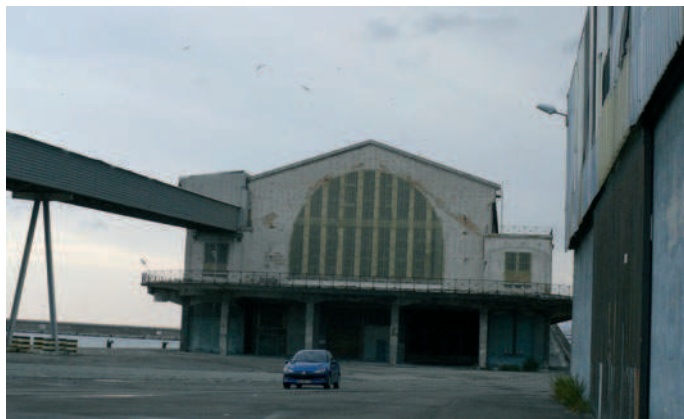
↑ Le repaire de nos trésors, le hangar numéro 14.
